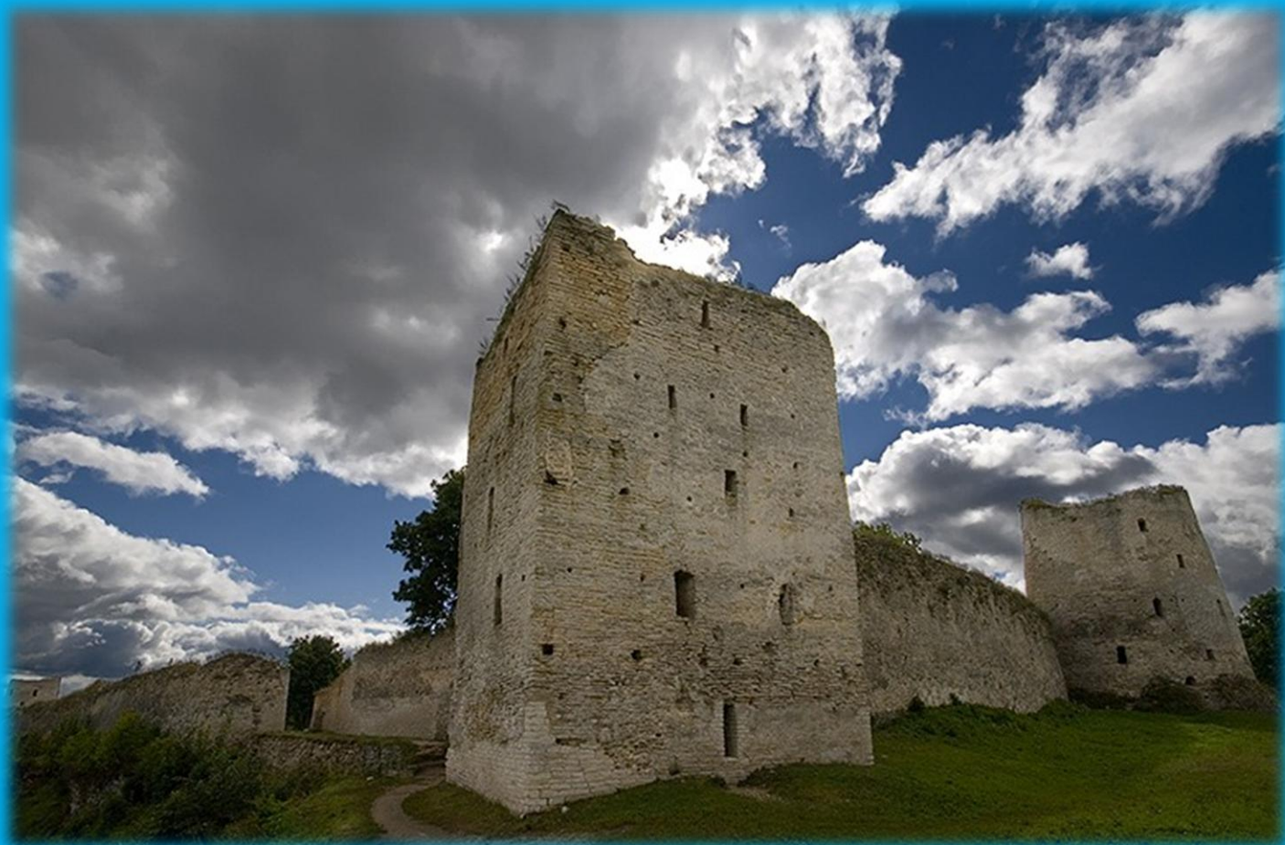
Современный вид крепости. Башня Галавская.
